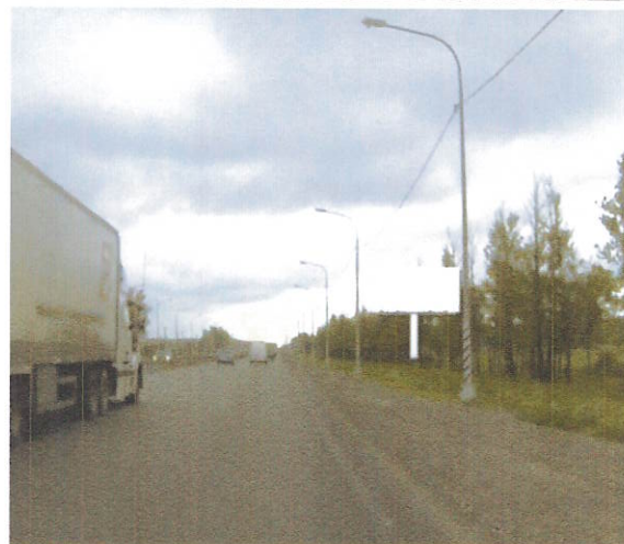
24 Автодорога Москва-Санкт-Петербург 668+700 км ЛС
