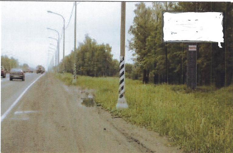
23 Автодорога Москва-Санкт-Петербург 669+105 км ЛС
