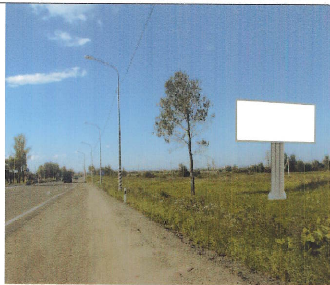
20 Автодорога Москва-Санкт-Петербург 670км+450м ПС
