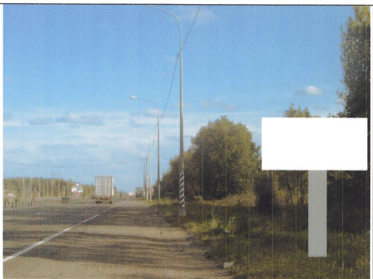
27 Автодорога Москва-Санкт-Петербург 667+450 км ЛС
